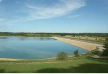
Canal de la Neste et barrage réservoir de la Gimone.
