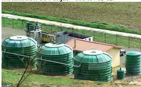
Installation de Panjas - Source : CD 32.
