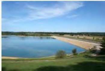
Canal de la Neste et barrage réservoir de la Gimone.
